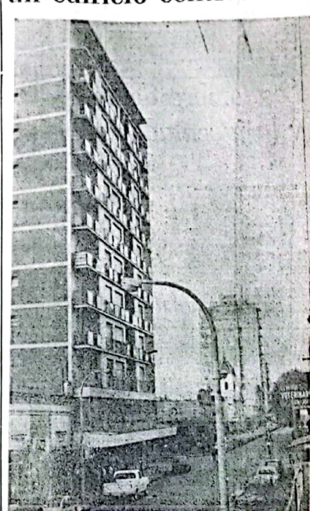
Diversas medidas de prevención fueron tomadas a raíz de haberse comprobado el estado precario de una de las columnas de acero del edificio de 11 plantas, ubicado en la esquina de Corrientes y Vicente López, en muestra ciudad, lo que obligó a guarnecer a distintos trabajos para asegurar su estabilidad. El grabado muestra el frente a Vicente López del conocido edificio de 11 plantas, ubicado en la esquina de Corrientes y Vicente López, en muestra ciudad, lo que obligó a guarnecer a distintos trabajos para asegurar su estabilidad. (Amplia información en página 2). (Foto: Di. Quilmas)
